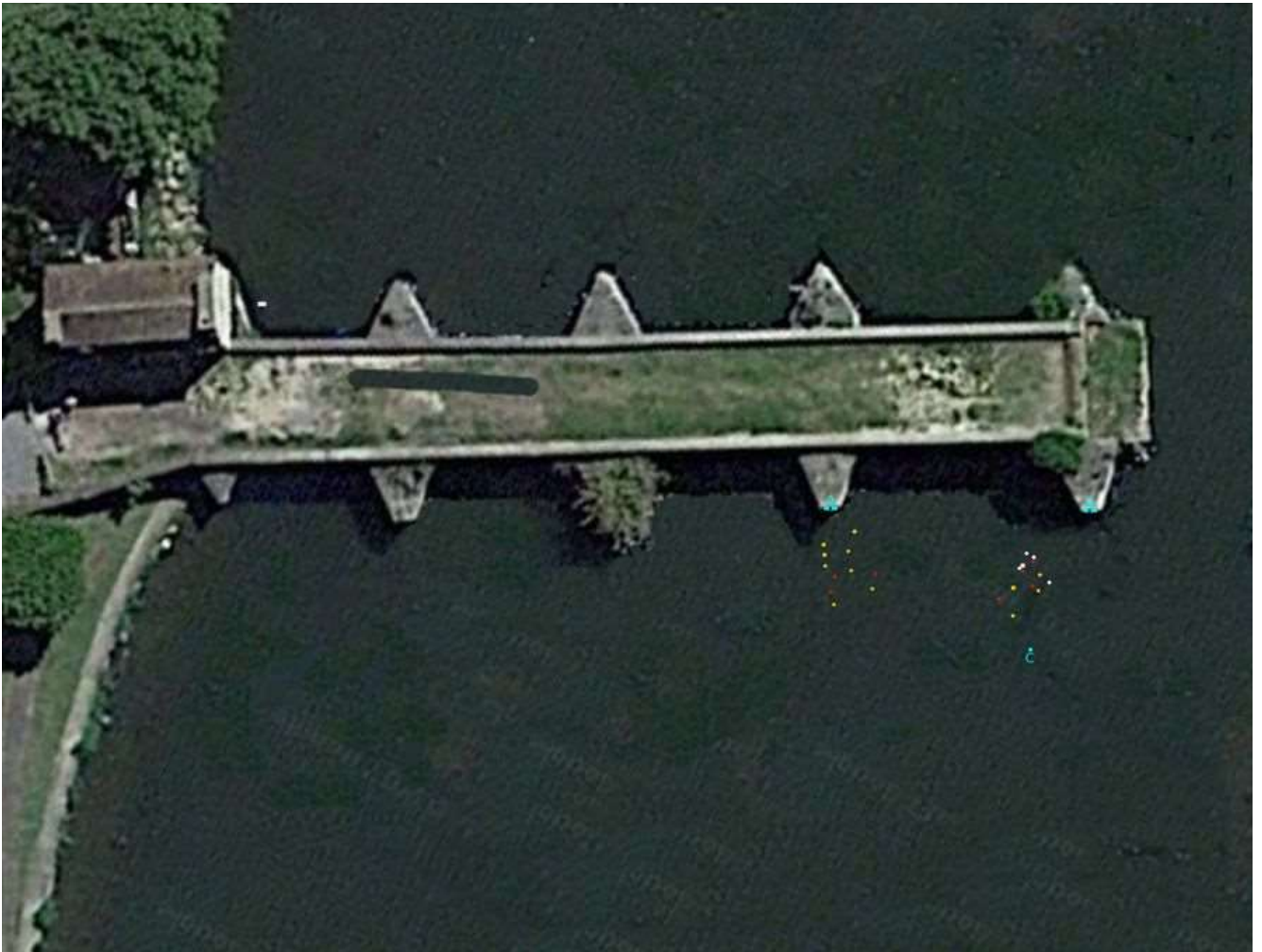
Figure II-11: Pilotis du moulin du pont de Limay – vue générale
