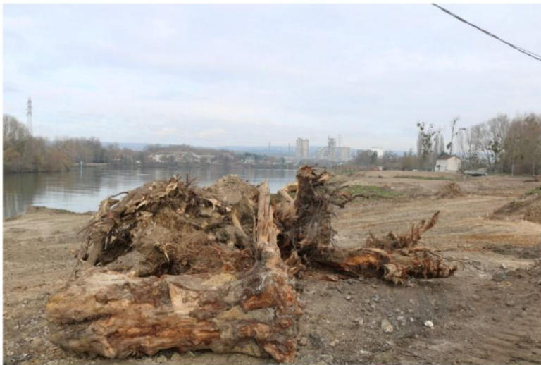
Près de 100 tonnes de matériaux amiantés ont été extraites. (© Méréva Balin/78 actu)
